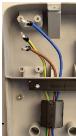
Installation des Ferritkerns
